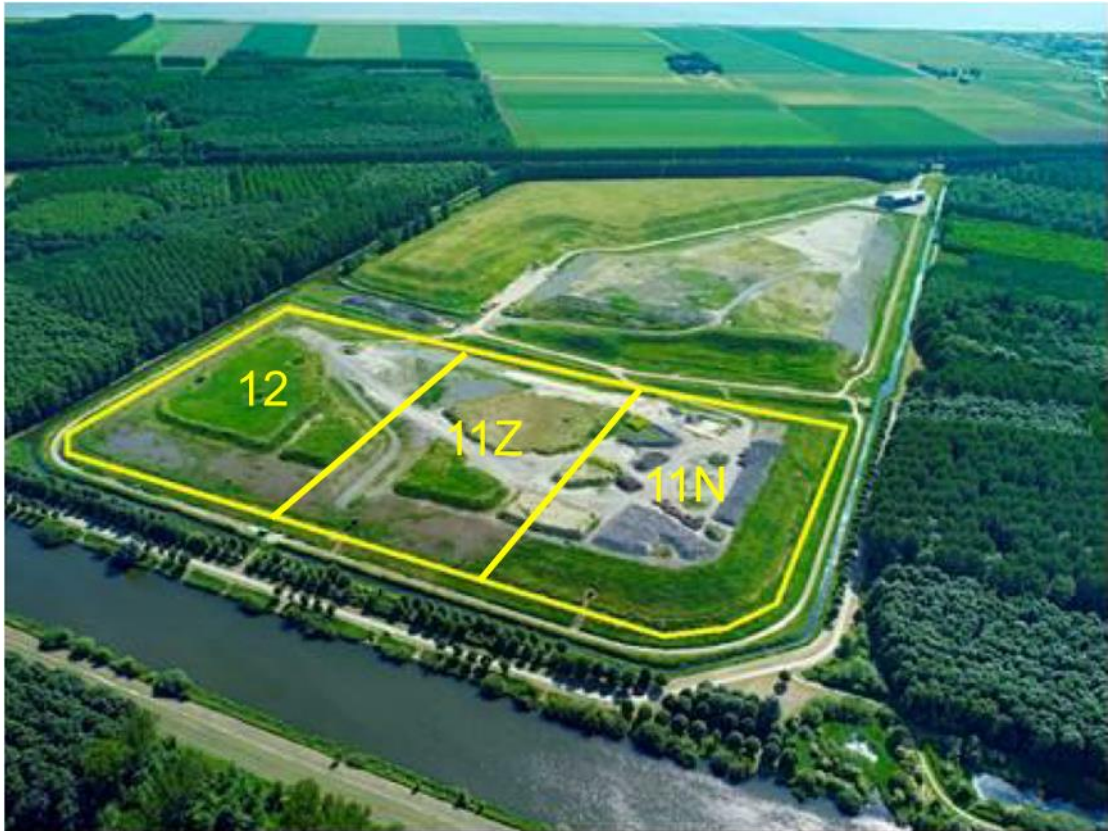
Figuur 4. Luchtfoto van stortplaats Braambergen met geel omlijnd compartimenten 11 en 12 (Vereniging Afvalbedrijven 2015a)
