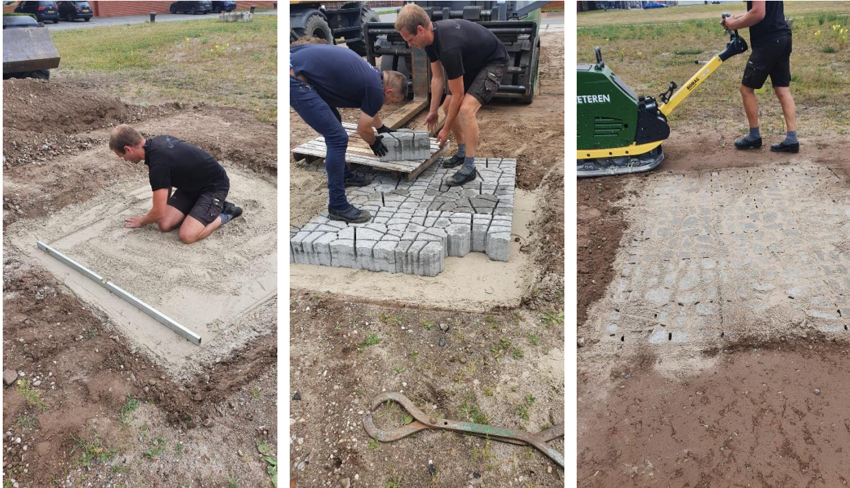
Figuur 16, 17 en 18: het vlak maken van het zandbed, het aanbrengen en het verdichten rondom (niet op de stenen).
