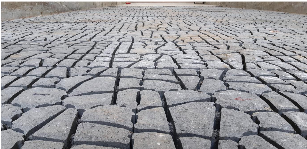
Figuren 1, 2 en 3: RONA ® ton XL, 4 individuele stenen, een set, en de zetstenen in een talud.
