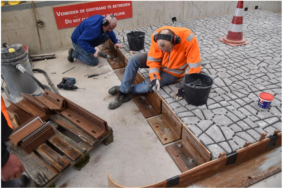
Fig. C-5, Stalen hoekprofielen monteren en ruimte tussen hoekprofielen en rubber opvullen met vulplaatjes
