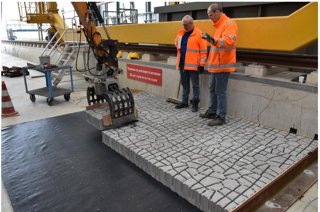
Fig. C-4, Plaatsing zetstenen met een minikraantje met sorteerknijper
