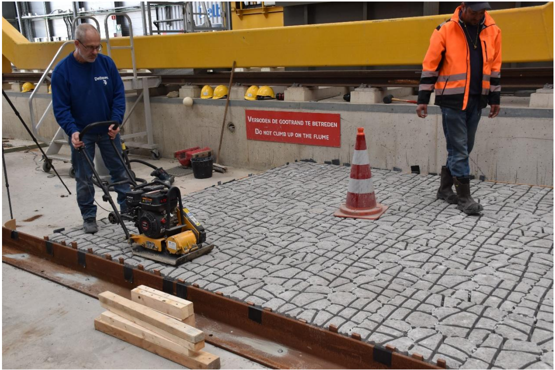
Fig. C-11, Na het inwassen met kleine trilplaat erover
