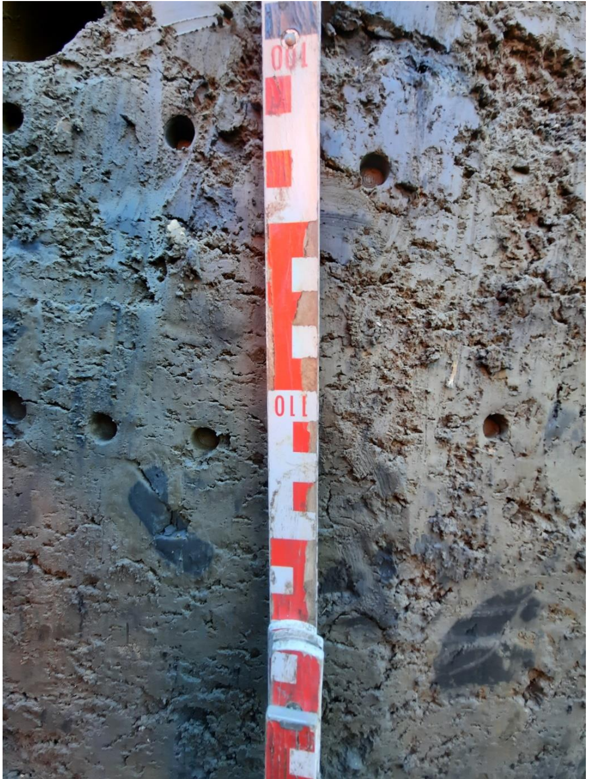
Figuur 3.5 Detailopname van profielkuil segment 2 met duidelijk zichtbare de blauwgrijze, slecht gerijpte kleilagen.
