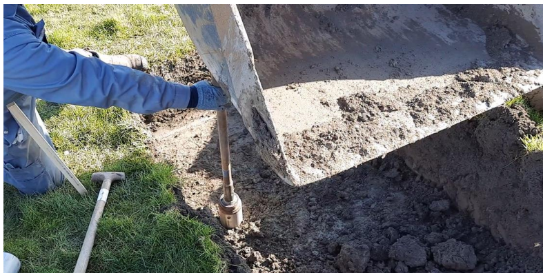
Figuur 3.1 Wegdrukken van een steekbus.
