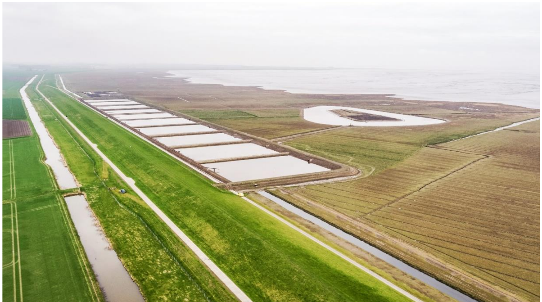
Figuur 2.2 Kleirijperij op de kwelder bij de Klutenplas, waar slib uit de polder Breebaart werd gerijpt (kleisoort nr. 2). De klei uit de ringdijk is ook gebruikt (kleisoort nr. 3).
