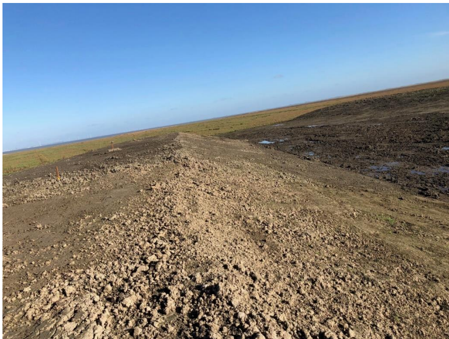
Proefdijk na aanleg [foto op 3 november 2020]
