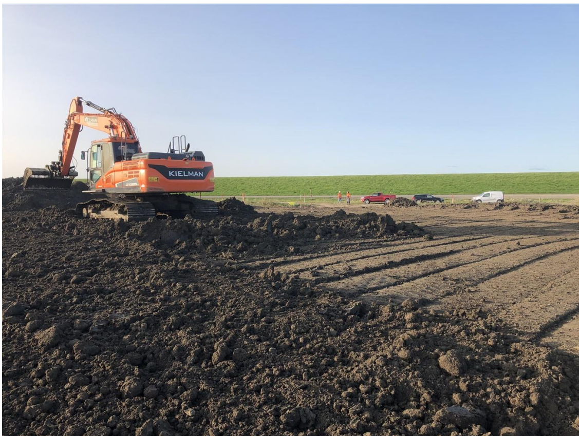
Figuur 10 (17 september aanbrengen 3 e laag van de Proefdijk)
