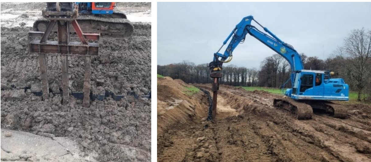
Figuur 5-4 Rupskraan met damwandstamper ontwikkelt voor kunststof damwandschermen
