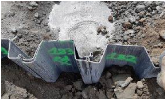
Figuur 6-5 Voorbeeld van de 'potdekselmethode'
