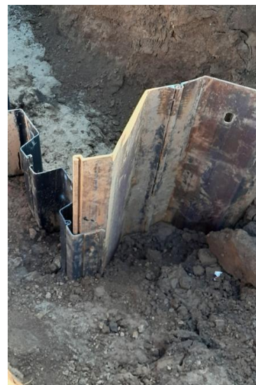
Figuur 4-4 Toepassen overgangsconstructie stalen AZ-profiel en kunststof profiel
