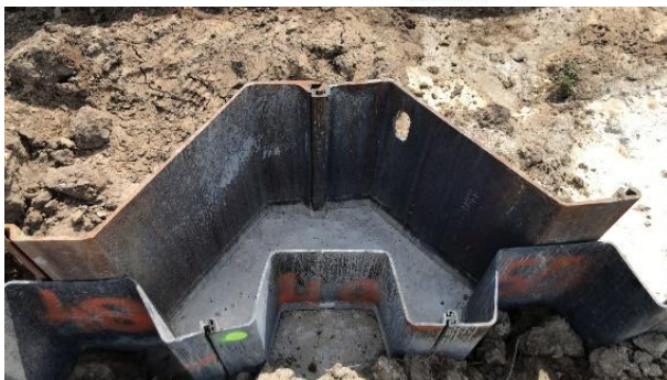
Figuur 6 Aanbrengen stalen damwandscherm
