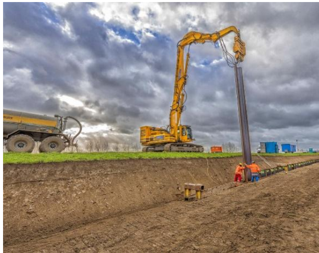
(4) Funderingsstelling met voorspanning (meedrukken)
