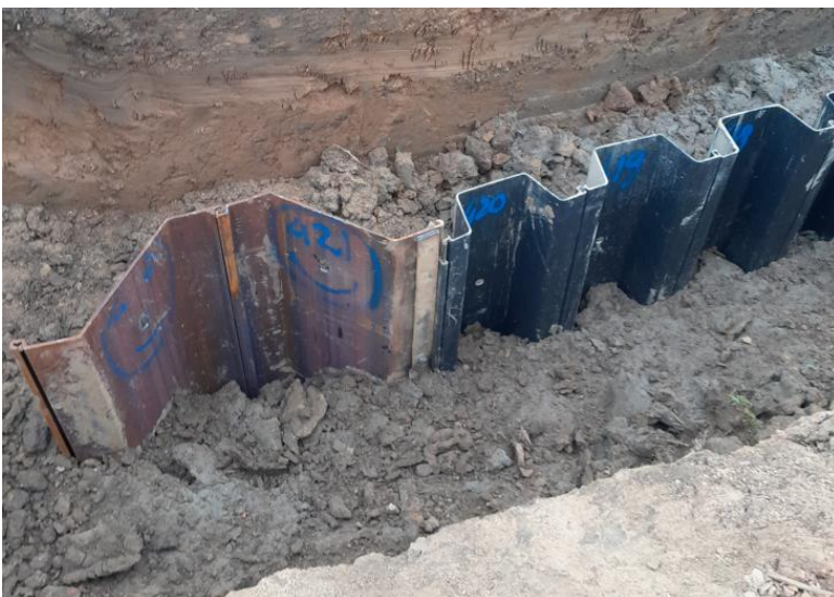
Figuur 4-4 Toepassen overgangsconstructie stalen AZ-profiel en kunststof profiel
