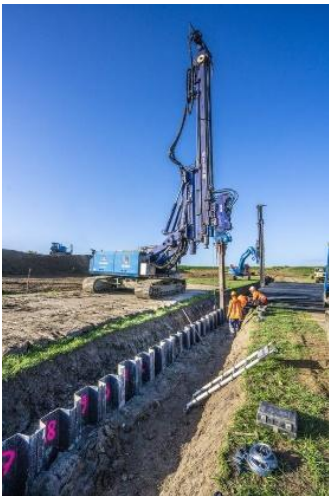
(3) Funderingsstelling met voorspanning (meedrukken of trekken)
