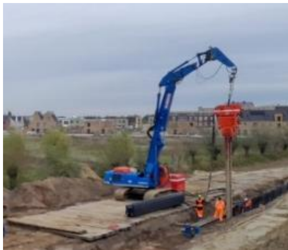
(2) Funderingsstelling met vrijhangend trilblok
