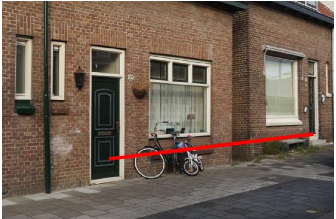
Figuur 5.5: Twee gebouwen waarvan het linker huis op staal is gefundeerd en het rechter huis op houten palen.
