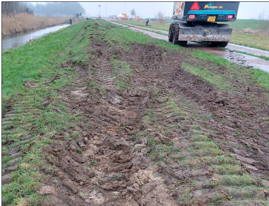
Figuur 6-7: leidingtracé aangereden met mobiele graafmachine
