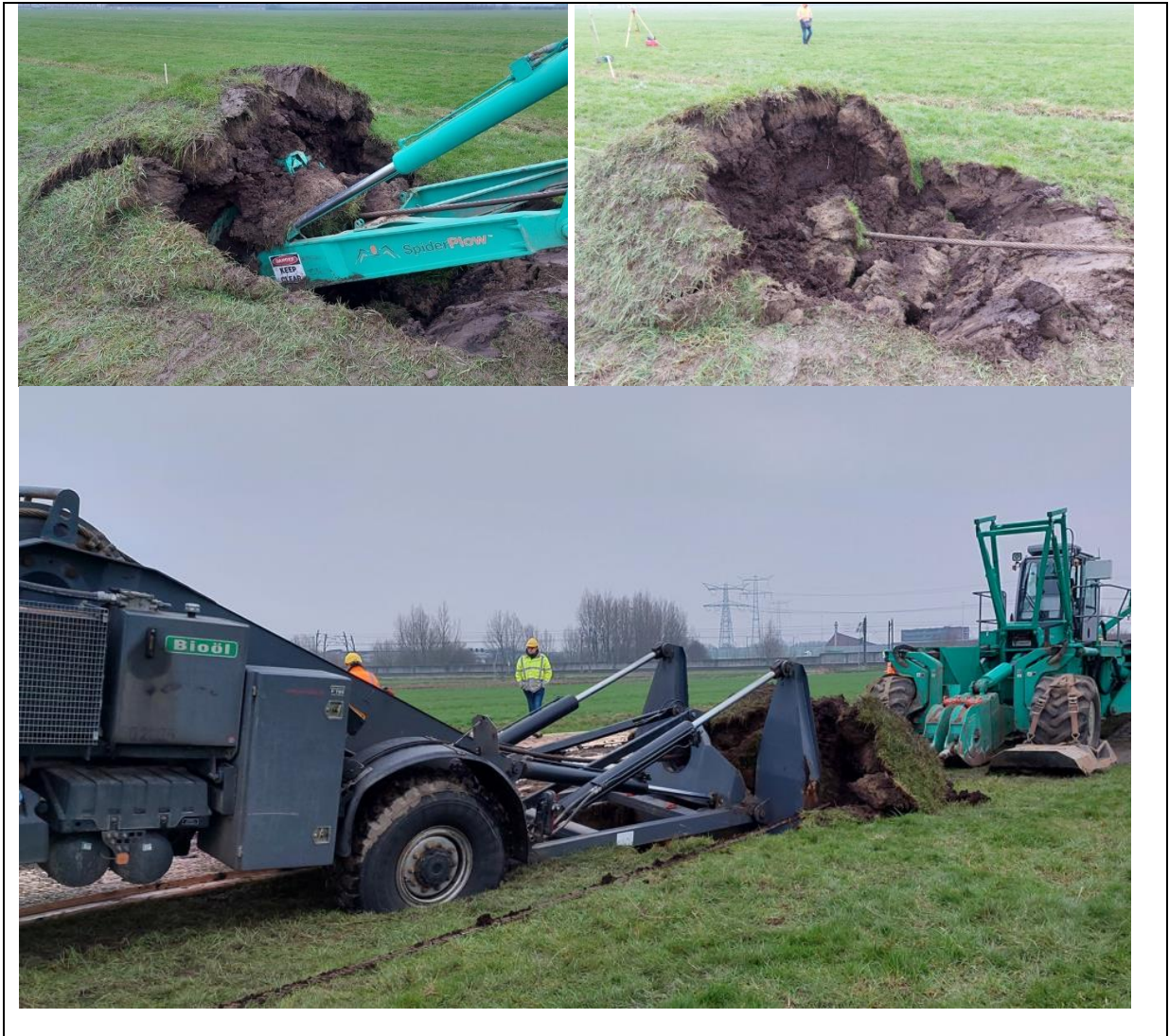
Figuur 7-7: Impact liervoertuigen 24 inch leiding
