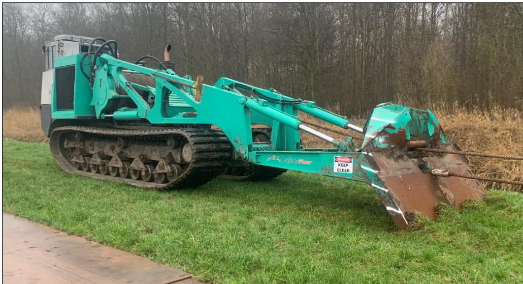
Figuur 3-3: Rupsvoertuig met lier. Door het oprollen van de staalkabel trekt deze de ploeg naar zich toe (bron: Deltares, Inploegen grote diameter Leidingen)
