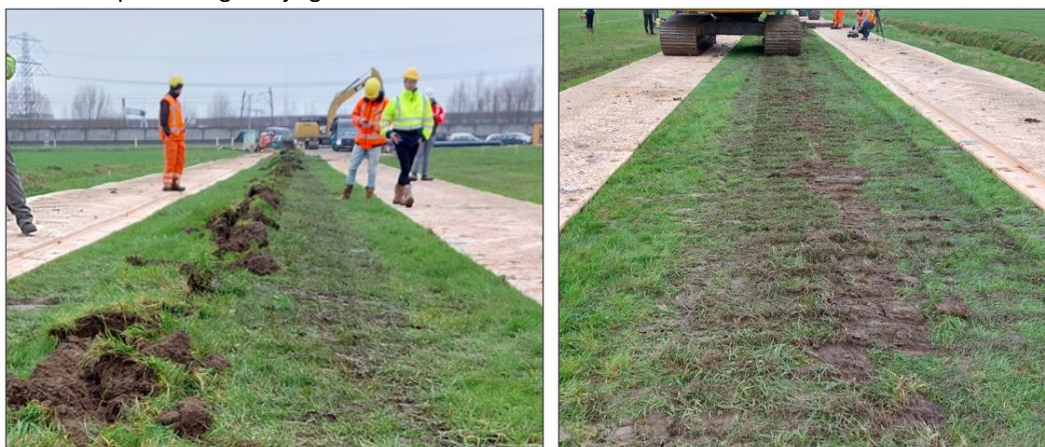
Figuur 7-2: linker foto de opgekomen grond van de 12 inch leiding, rechter foto na aanrupsen overeenkomend met de nul-meting
