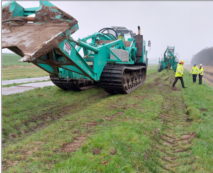
Figuur 6-5: verdichten middels aanrupsen door liervoertuig
