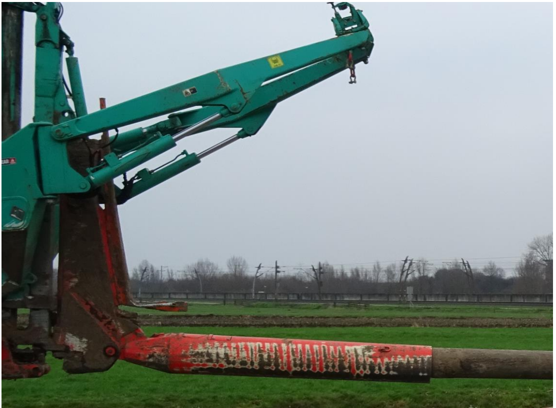
Figuur 2.7 Detail opname torpedo met 12" leiding (foto: Deltares).
