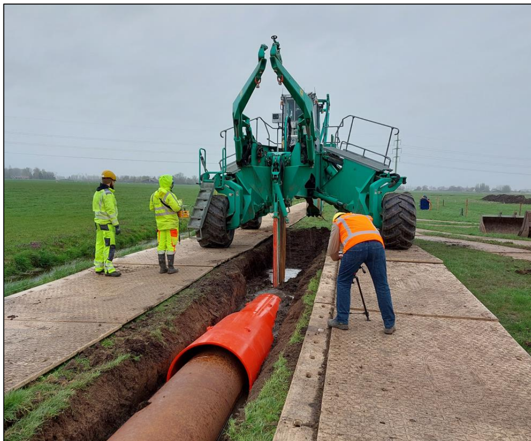
Figuur 3-5: Detail opname 16" torpedo met 28" leiding.
