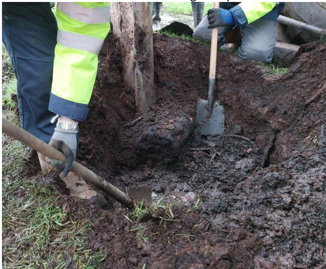
Figuur 7-6: Vastlopen van de ploeg op een onverteerde boomstam
