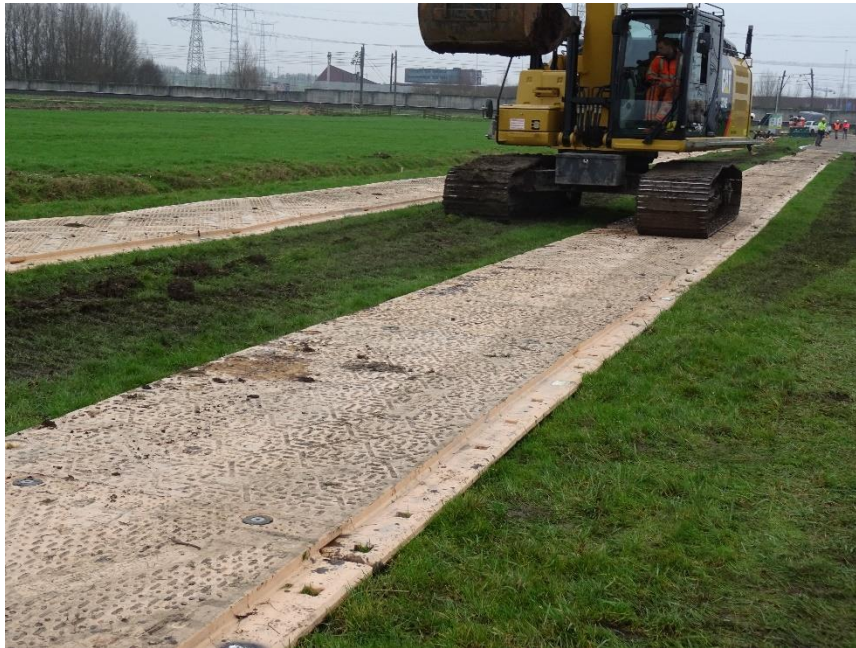
Figuur 6.12 Terrein na inploegen 12" leiding en aanrupsen (foto: Deltares).
