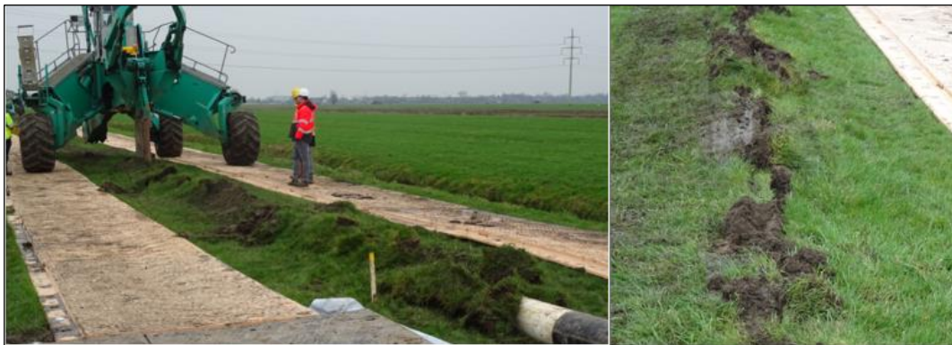
Figuur 3-6: Grondvervorming rond zwaard, locatie Sliedrecht (bron: Deltares, Inploegen grote diameter Leidingen).
