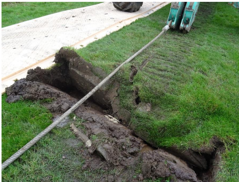
Figuur 6.13 Verstoring bodem ter plaatse van schuifbord lier, opname na intrekken 12" leiding Sliedrecht (foto: Deltares).
