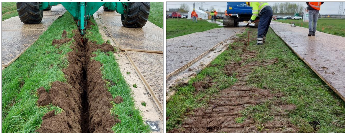
Figuur 5-1: linker foto de opgekomen grond van de 28 inch leiding, rechter foto na aanrupsen overeenkomend met de nul-meting
