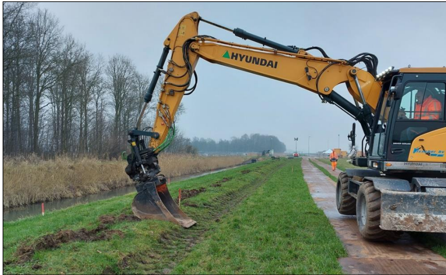
Figuur 6-6: verdichten middels aandrukken met bak
