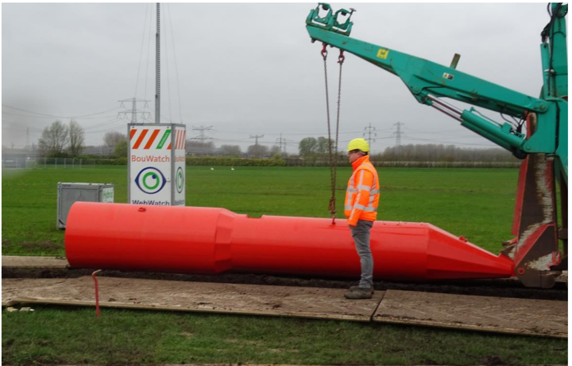
Figuur 2.9 Torpedo voor 28" leiding (foto: Deltares).
