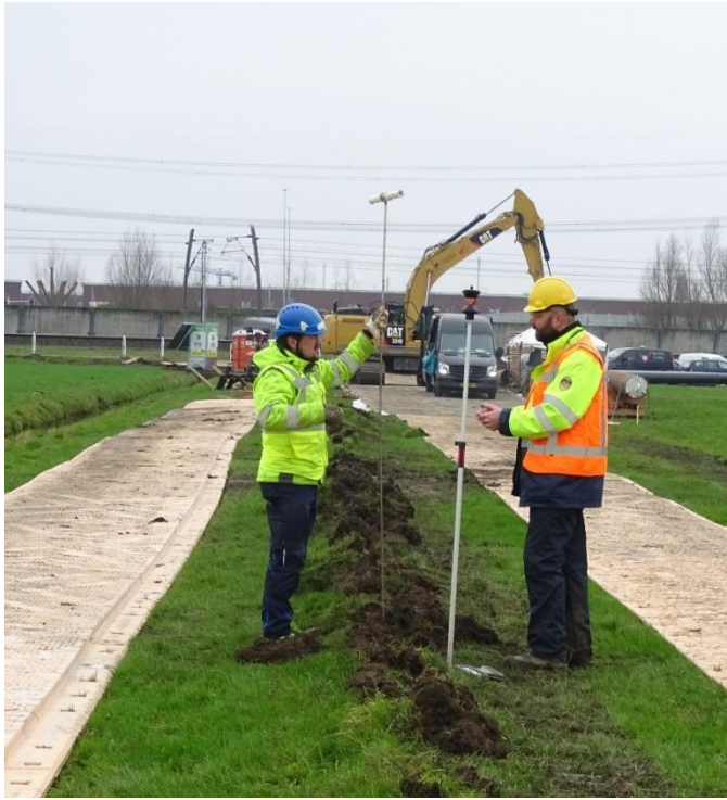
Figuur 4.4 Meten diepteligging leiding (foto: Deltares).
