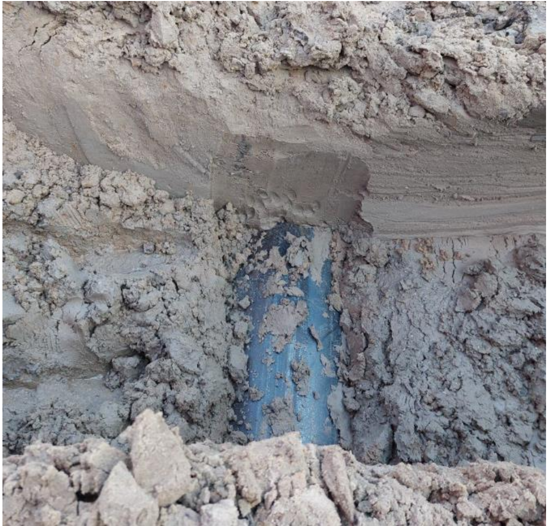
Figuur 5.17 Ligging van de leiding van ploeglijn 3 (Noord). (Foto Antea).
