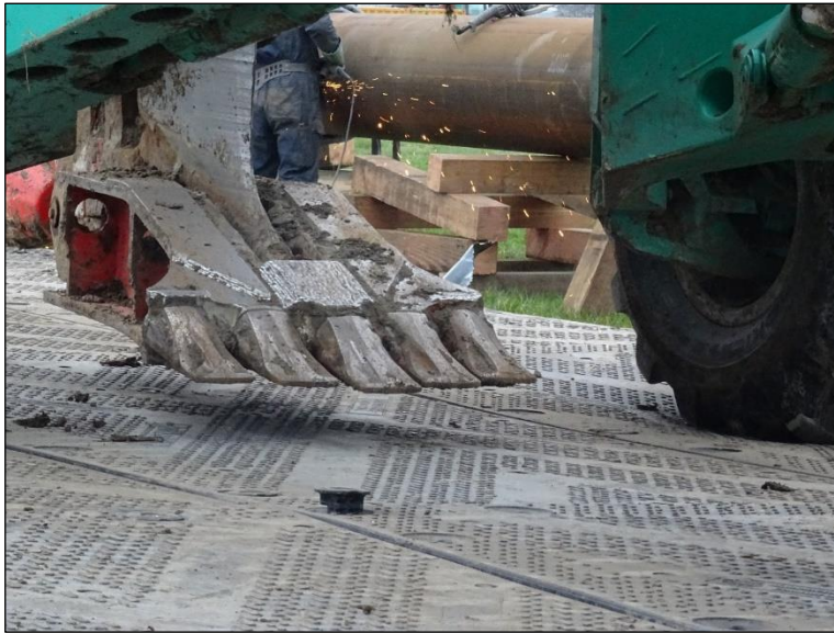
Figuur 3-5: Detail opname ripper shoe, tevens is onderste deel zwaard te zien (bron: Deltares, Inploegen grote diameter Leidingen).
