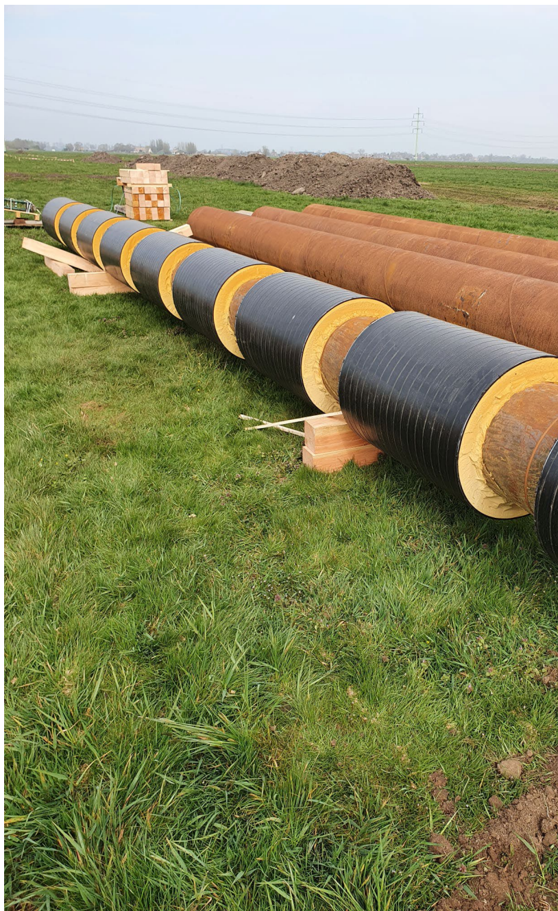
Geprepareerde VPS buis om veldlassen te kunnen aanbrengen.
