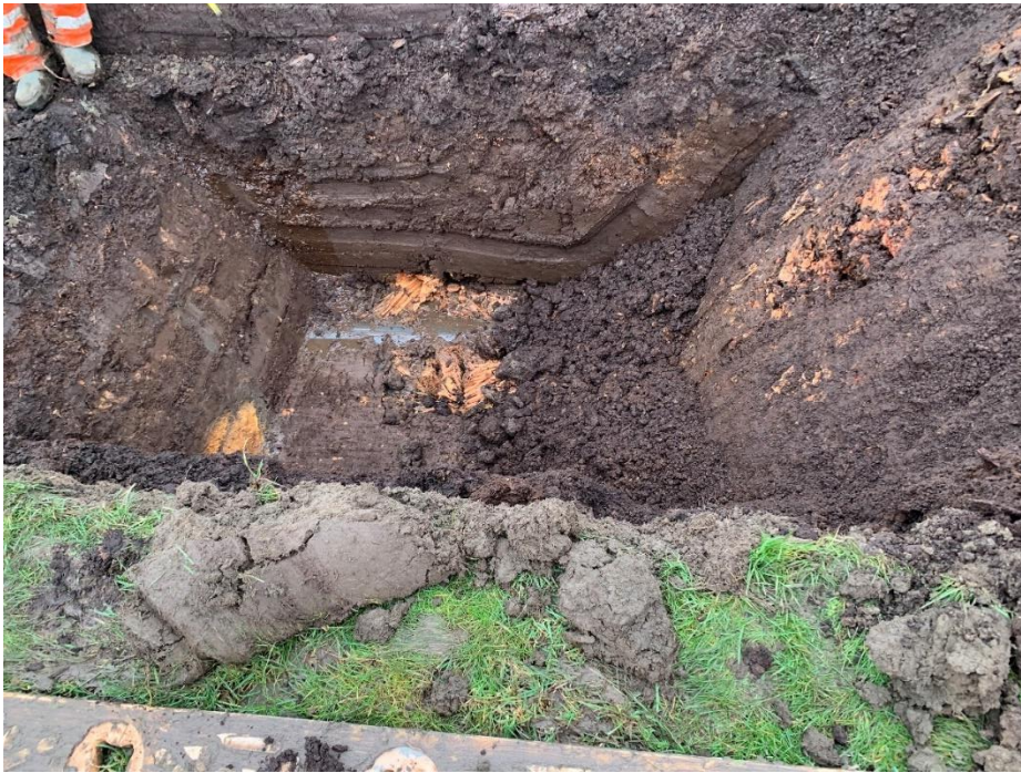
Figuur 6.14 Ligging van de leiding van ploeglijn 4 (12") (foto: Deltares).
