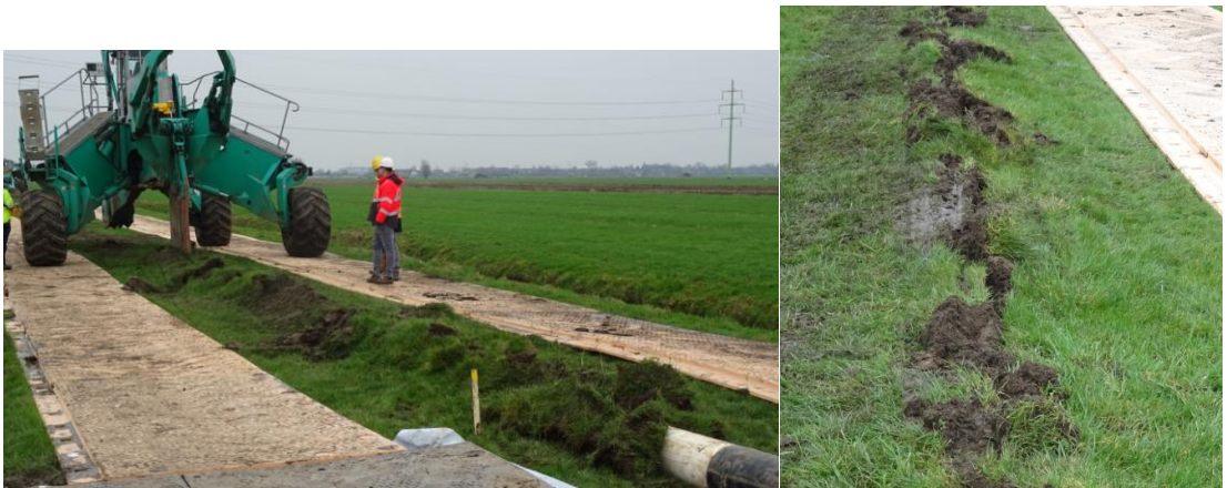
Figuur 2.6 Grondvorming direct na inploegen en voorafgaand aan aandrukken, locatie Sliedrecht, 12" leiding (foto: Deltares).
