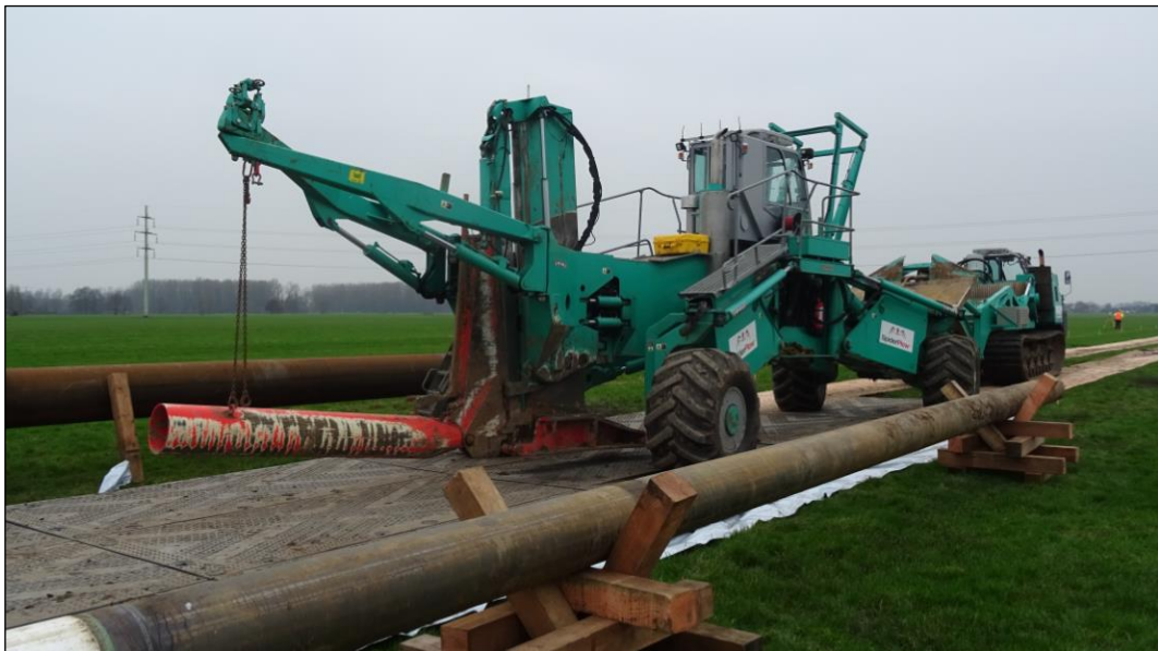
Figuur 3-1: De ploeg en daarachter de lier (bron: Deltares, Inploegen grote diameter Leidingen)
