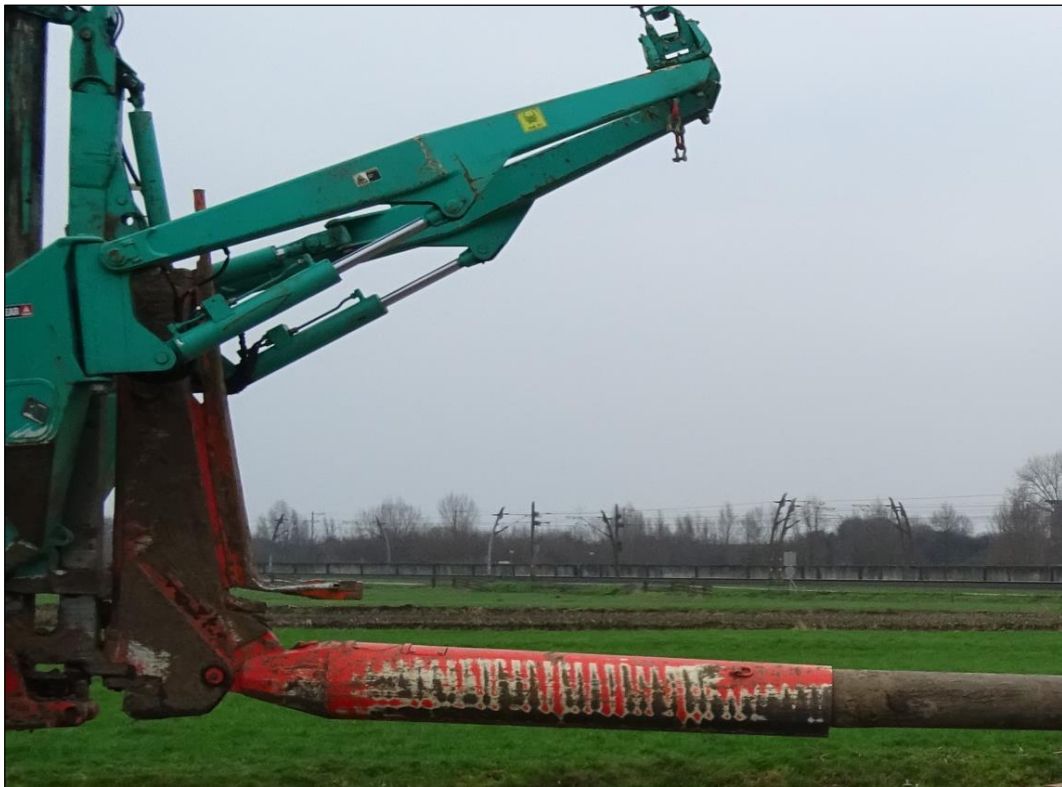
Figuur 3-7: Detail opname 16"torpedo met 12" leiding (bron: Deltares, Inploegen grote diameter Leidingen).
