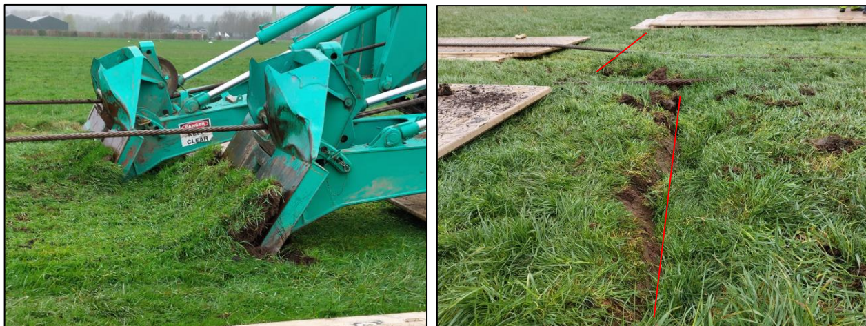
Figuur 5-3: Liervoertuigen bij intrekken 28 inch leiding
