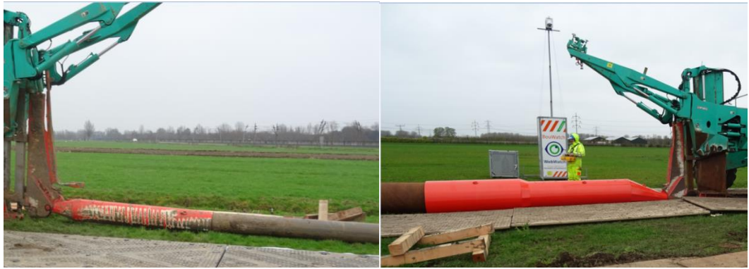
Figuur 2-2 Torpedo met leiding, links 12" leiding, recht 28" leiding (foto: Deltares).
