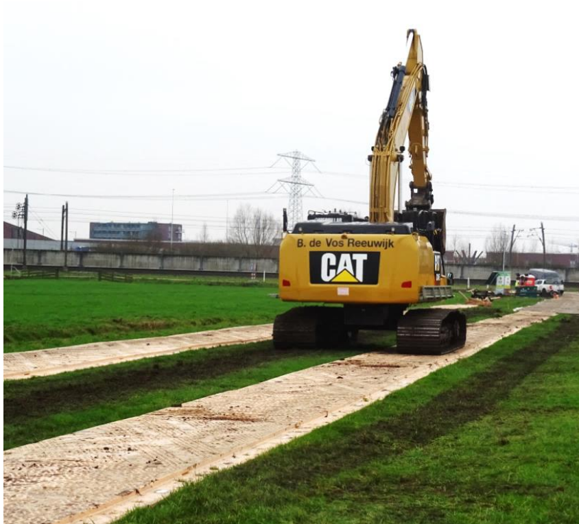
Figuur 2-6 Ploegvoor en maaiveld na aanrijden met een rupsvoertuig (het zogenaamde 'aanrupsen'), locatie test Sliedrecht (foto: Deltares).
