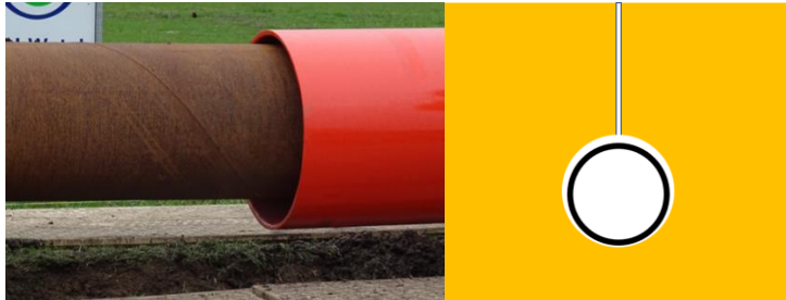
Figuur 4-10 Situatie van de leiding direct achter de torpedo (foto: Deltares).
