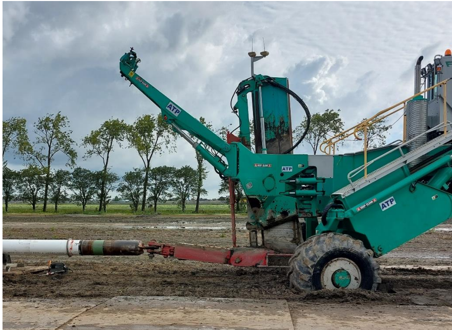
Figuur 2-3 Ploeg zonder torpedo, de leiding is direct aan de ripper shoe gekoppeld (foto: Deltares).
