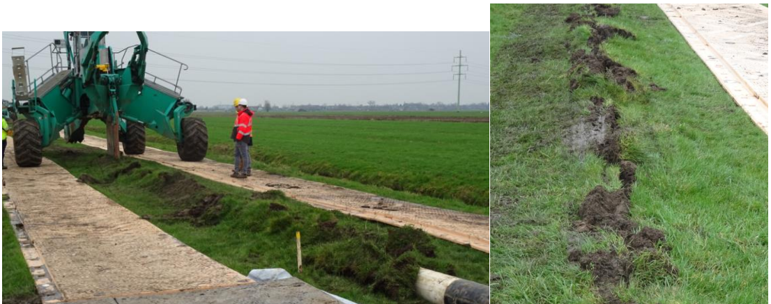
Figuur 2-5 Grondvervorming bij intrekken, locatie test Sliedrecht (foto: Deltares).
