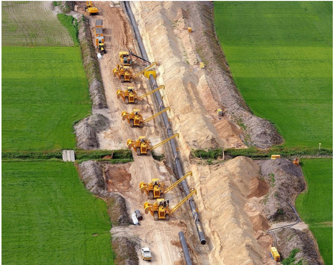
Figuur 1-1 Voorbeeld traditionele aanleg leiding in een sleuf (Foto: A. Hak).
