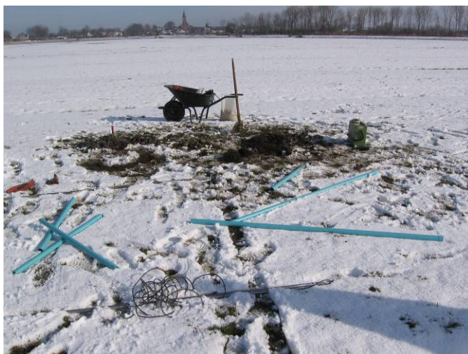
Figuur 15: Plaatsing peilbuizen
